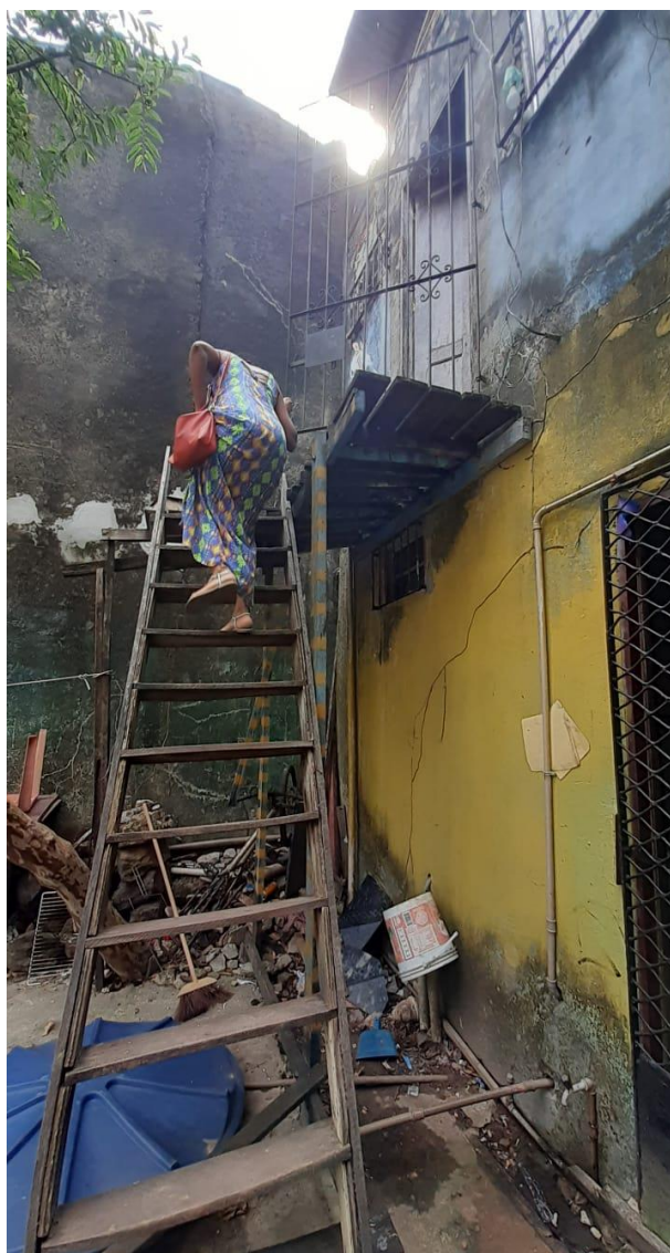
Imagem 4. Escada que dá acesso à casa (alugada) de Bia
