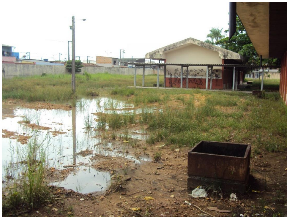
Figura 12 – Área com acúmulo de água parada
