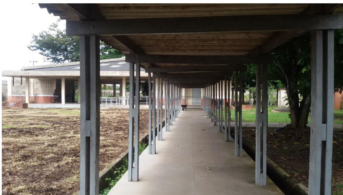
Figura 10 – Passarela de acesso as salas de aula.
