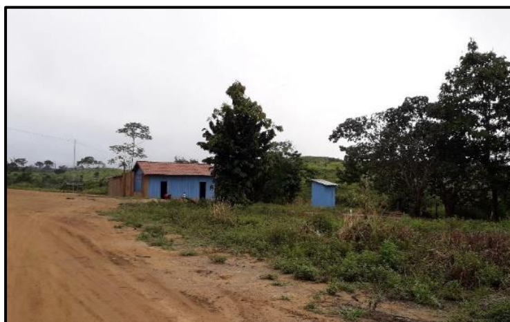
Figura 18 – Estrutura física da escola Maria de Nazaré
