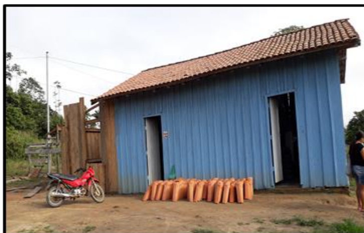
Figura 19 – Estrutura física da escola Maria de Nazaré
