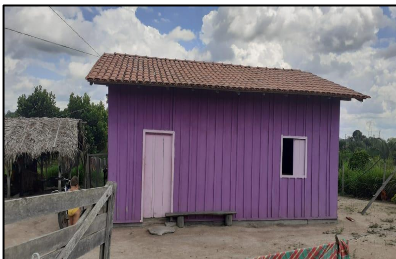
Figura 15 – Residência de madeira, coberta com telha de barro
