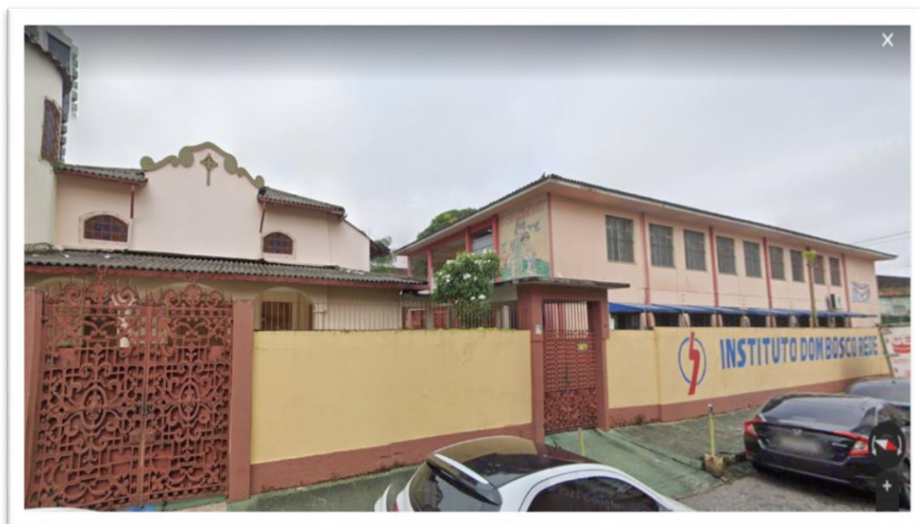
Figura 22 – Capela e Escola do Instituto Dom Bosco de Belém.
