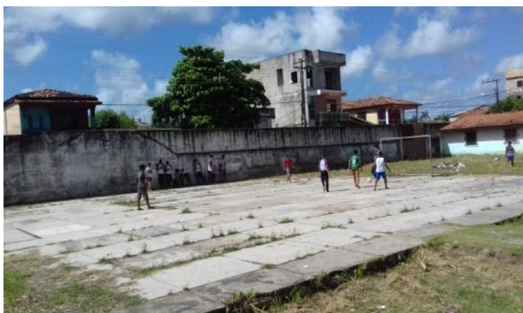
Imagem 15 Área de concreto (Quadra esportiva ESAM)
