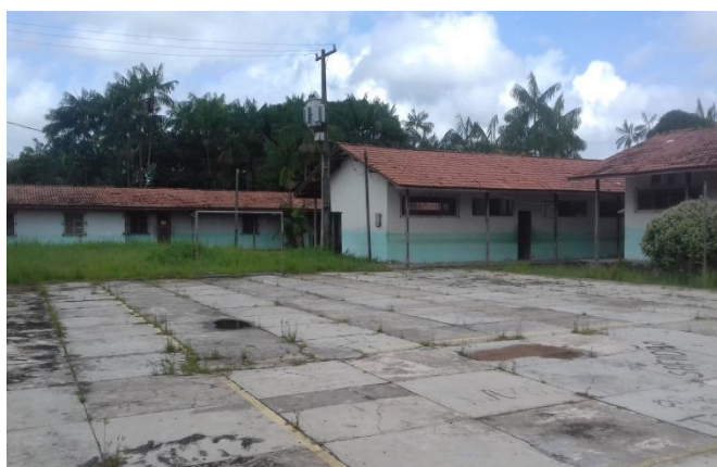
Imagem 3 Blocos de sala de aula
