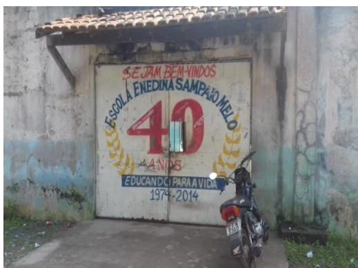
Imagem 1 Portão de entrada da escola
