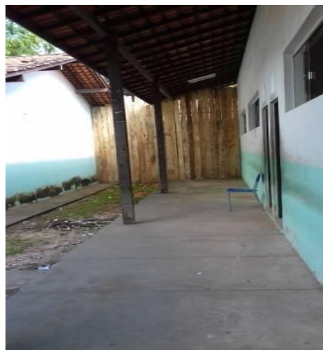
Imagem 18 Cerca de madeira: isolamento da parte final do bloco de sala de aula
