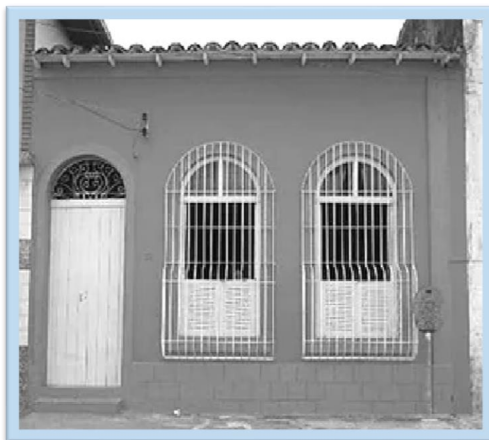
Figura 13 - Parte que restou da residência do prof. Araújo Nunes
