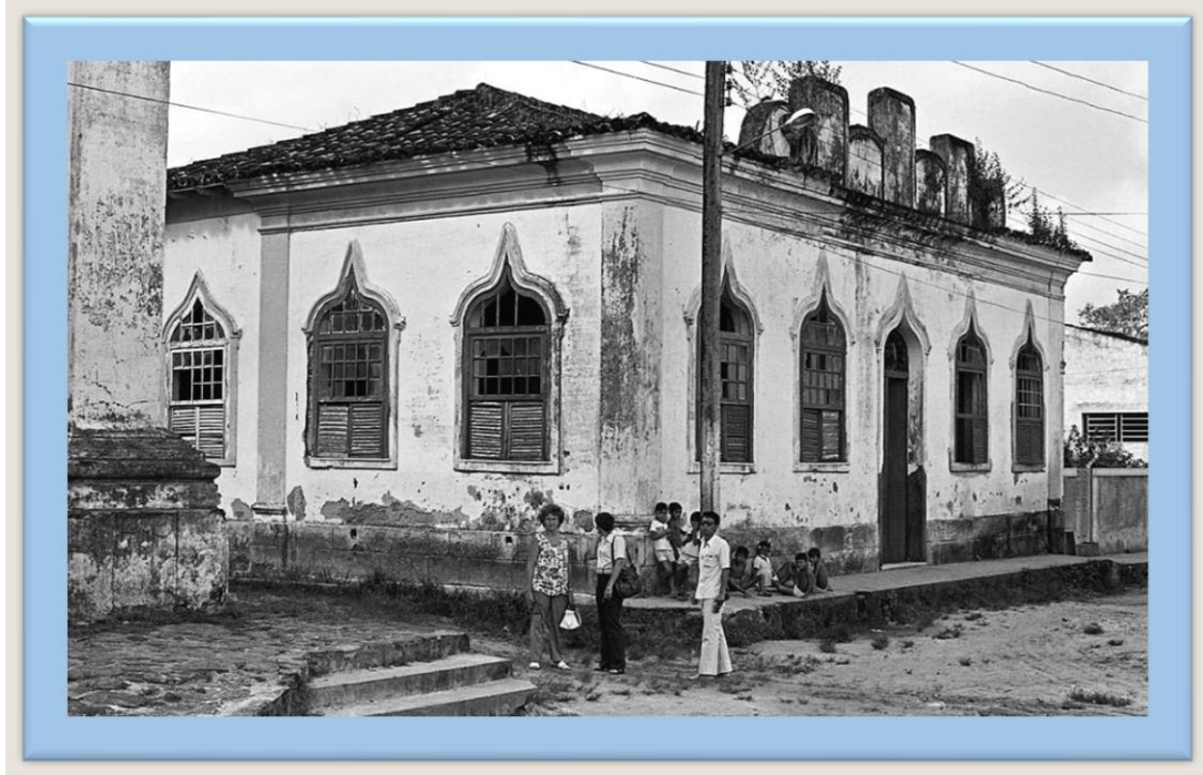
Figura 3 - Prédio do colégio Jesuíta de Vigia.
