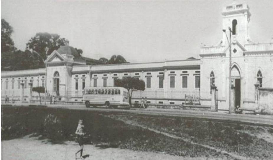
Foto 01 – Prédio do Hospital Juliano Moreira e da Igreja do Sagrado Coração de Jesus Fonte: Ricci e Valentin (2009, p. 26).
