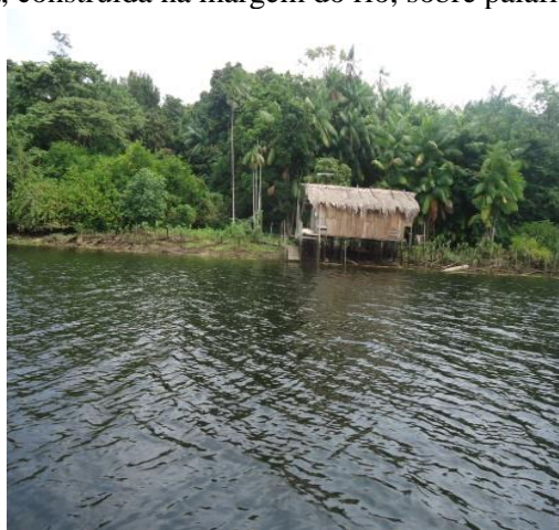
Figura 11 – Residências típicas das populações ribeirinhas do rio Guajará, construída na margem do rio, sobre palafitas, 2015
