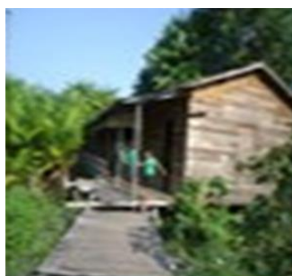
Figura 23 – Espaço construído para funcionar como anexo da Escola Núcleo Maria das Dores Sá
