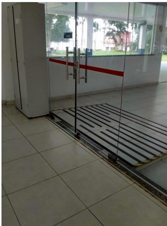
Figura 28 - Rampa de Acesso ao Refeitório na Indústria Alimentícia Palma
