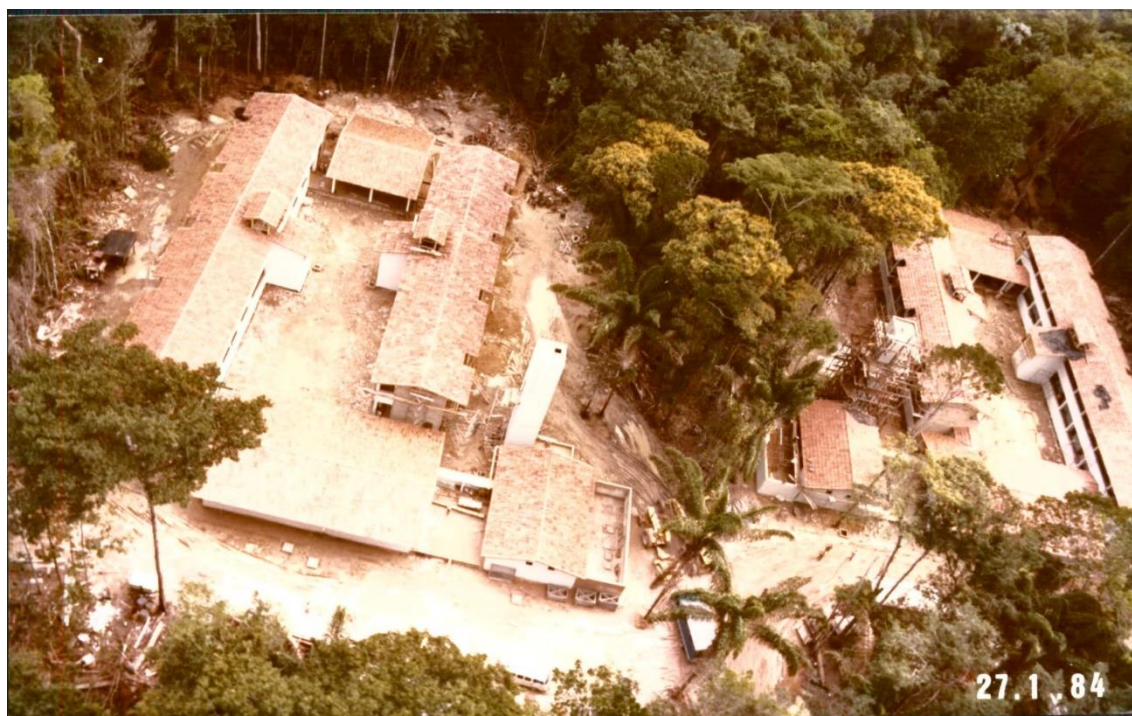
Figura 6- Construção do Colégio na Vila dos Cabanos, em janeiro de 1984
