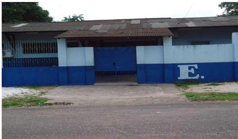
Foto: 01- Fachada da E.E.E.F.M. Casa do saber.
