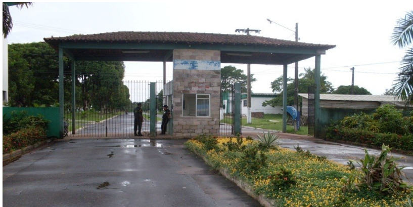
Foto 2: Portão de Entrada do Instituto Federal de Educação, Ciência e Tecnologia do Pará - IFPA Campus Castanhal.
