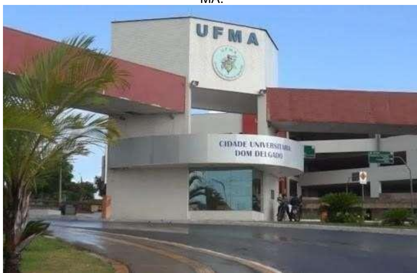
Ilustração 1 – Faixada de Entrada da Universidade Federal do Maranhão –Campus de São Luís – MA.
