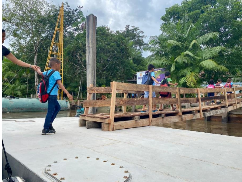
IMAGEM 4: Porto da Escola Milton Monte em reforma.
