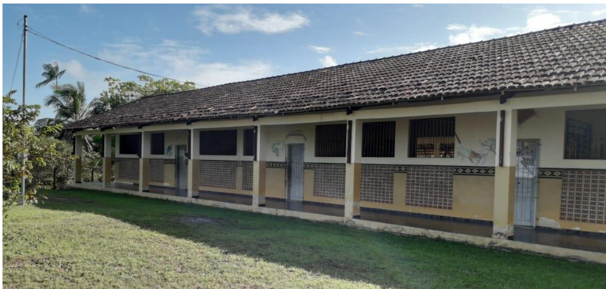
Figura 6 - Fachada da Escola Indígena Francisco Magno Tembé
