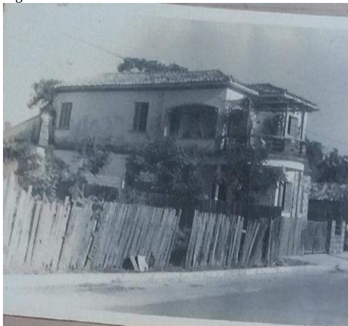
Figura 34 – Prédio do Escritório Central do SERB.
