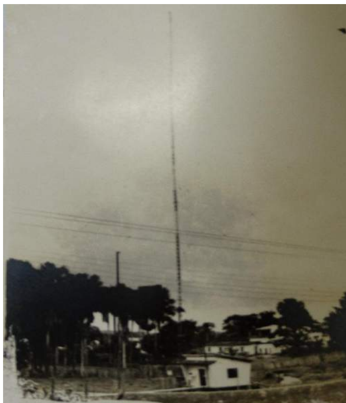
Figura 37 – Casa do Transmissor de Onda Tropical.
