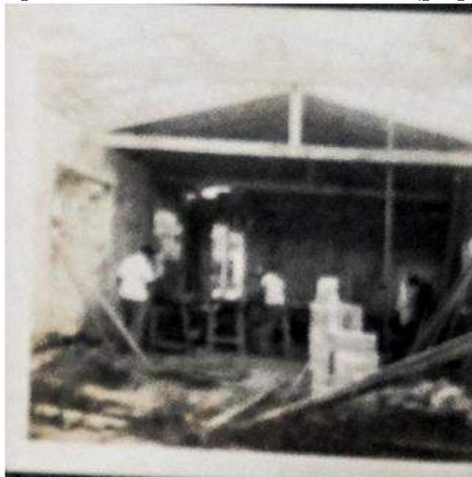
Figura 33 – Oficina anexa ao Escritório do SERB (garagem).
