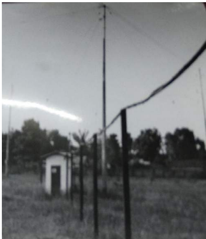
Figura 38 – Casa do Transmissor de Onda Média.
