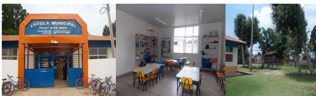
Figura 1. Escola Municipal de Educação Infantil Profª.Rita Nery, Belém – PA. A. vista frontal; B. Sala ambiente e C. Área Externa.
