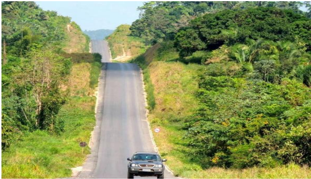
Imagem 16. Trecho da rodovia transamazônica asfaltada
