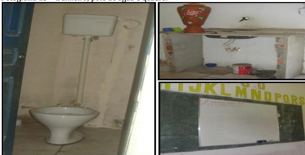
Fotografia 23 – Banheiro, pote de água e quadro.
