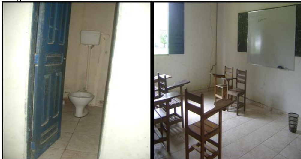
Fotografia 17 – Sala de aula e do banheiro.
