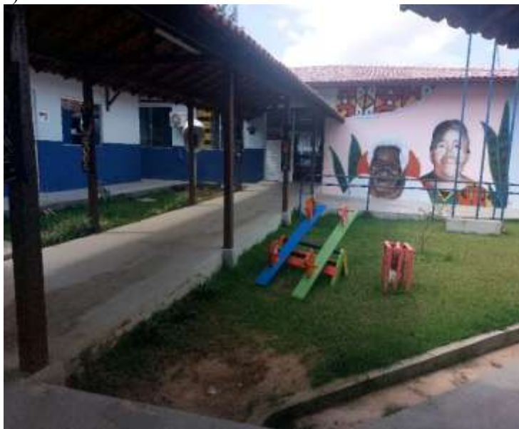
Figura 13 – Escola Municipal de Educação Quilombola Arlida Gomes (Entrada da escola após a reforma)
